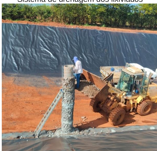
Sistema de drenagem de gases (Registro fotográfico próprio, 2024)
