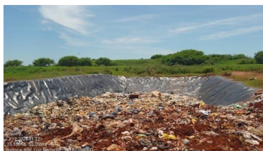
Geomembrana de impermeabilização
