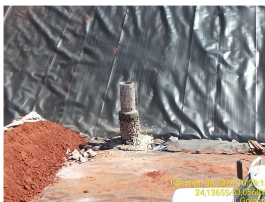
Sistema de drenagem de gases (Registro fotográfico próprio, 2024)
